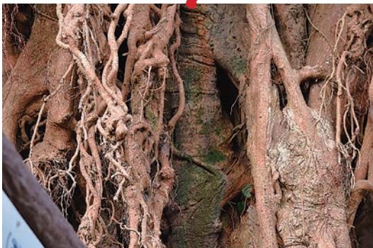
写真 4－2 腐朽部東①
