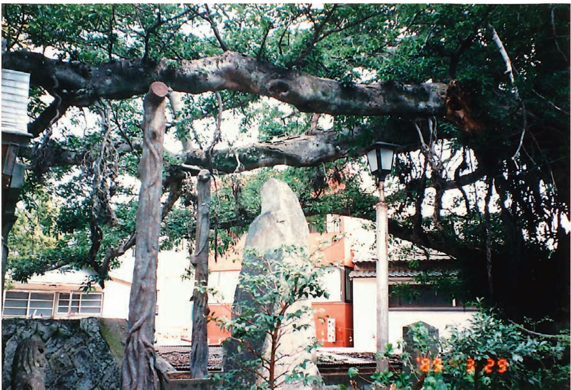
写真 2－2 支柱設置後写真（平成元年）
