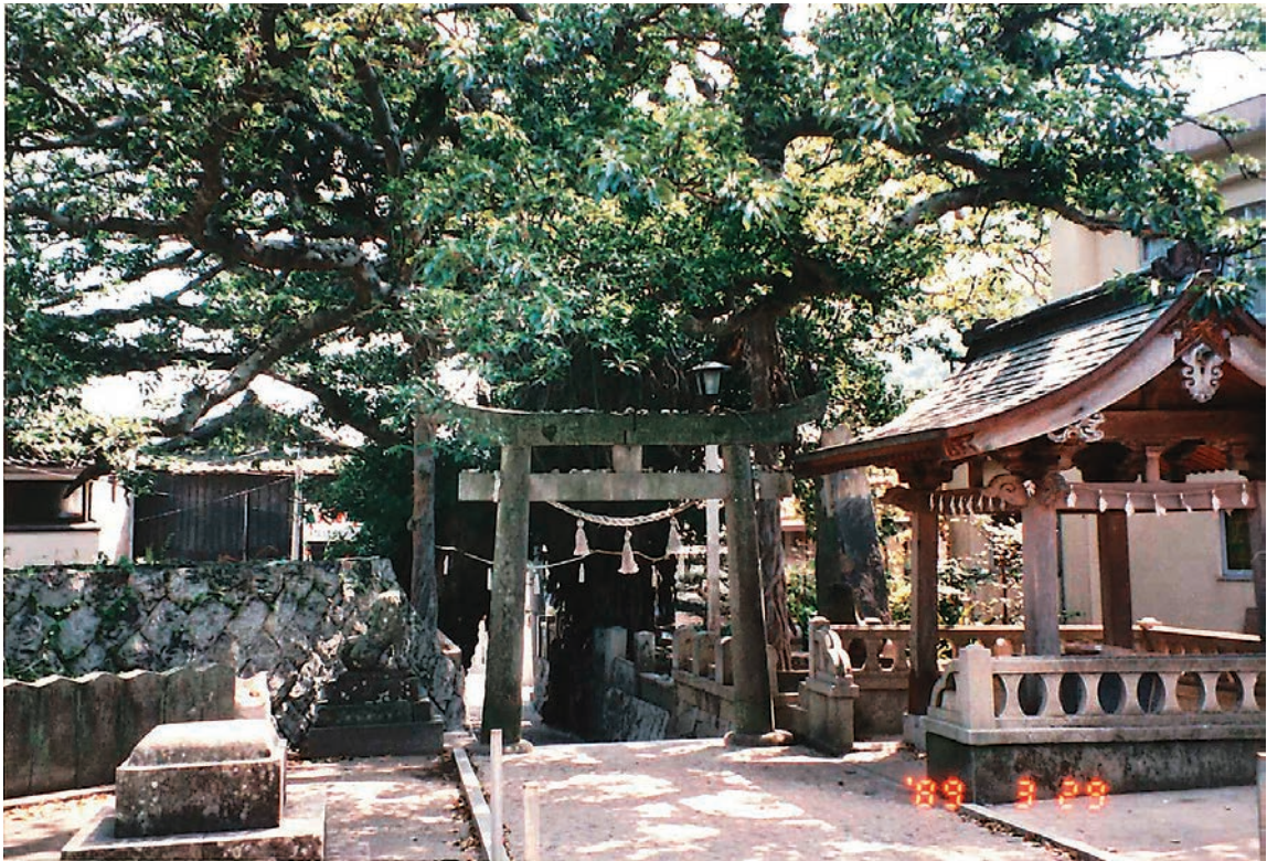
写真 2－1 支柱設置後写真（平成元年）
