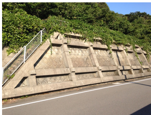
法面緑化（将来的にはツタも伸びてコンクリート擁壁を覆う）
