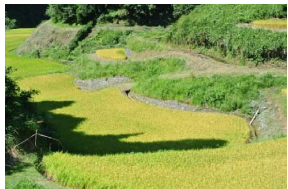
農道下の土羽の法尻には切石積みを用いている
