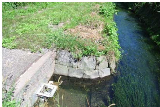
井手の護岸には切石積みを用いている
