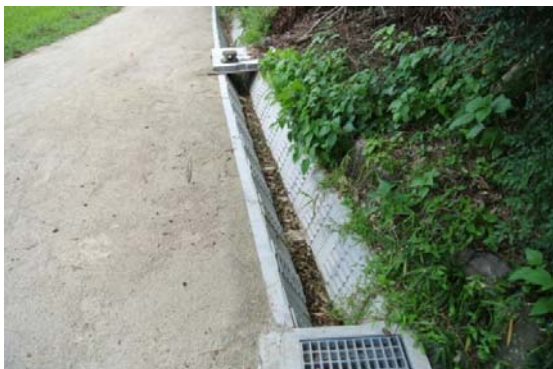
山からの雨水が路面に流れないように側溝を設置
