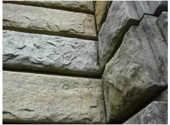
頭ヶ島天主堂の外壁に使われている砂岩
