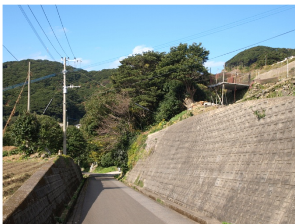
コンクリート堀（修景の対象）
