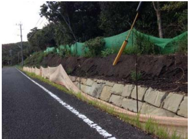
県道沿い法面に砂岩を使用
