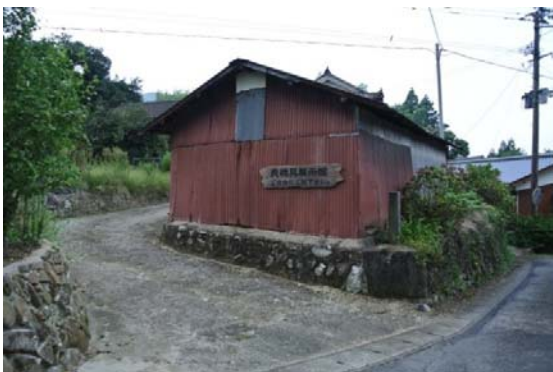
修理予定の馬屋（重要構成要素）
