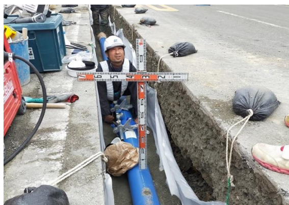
画像2-7(2) 管路更新
