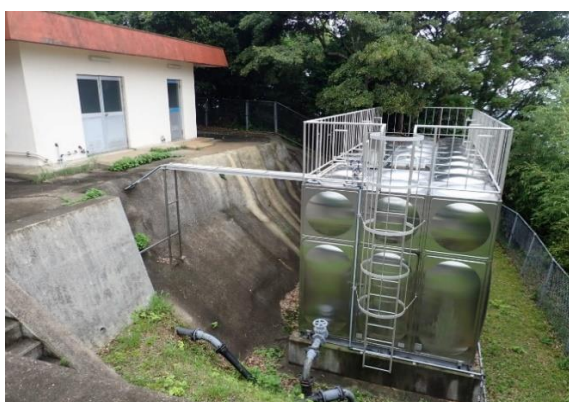
画像2-7(2) 丸尾配水池
