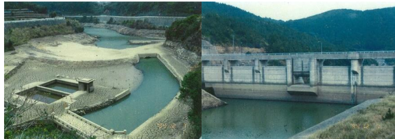
【上五島地区 青方ダム 平成6年渇水による被害】
