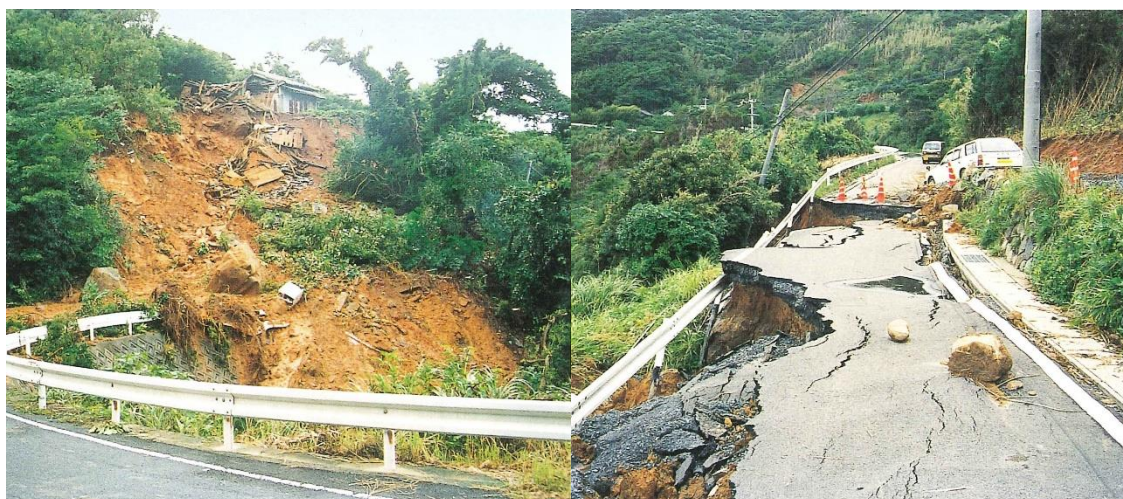
小瀬良地区の道路災害
